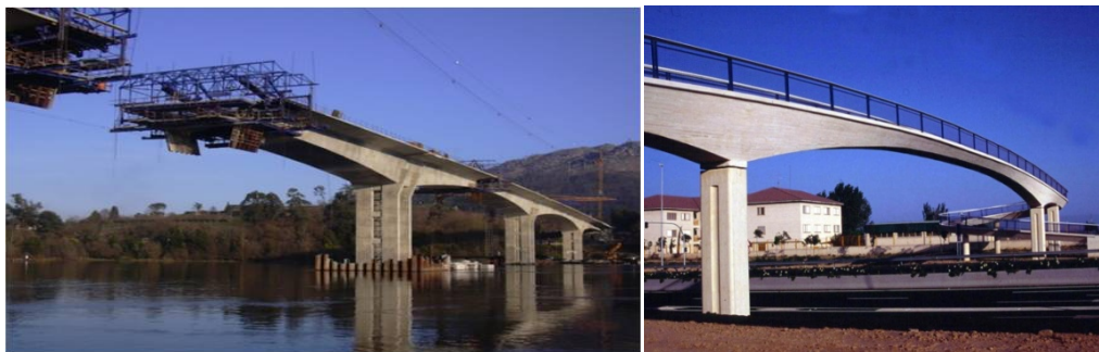
Imagen 3-15. Puente postensado in situ de canto variable.
