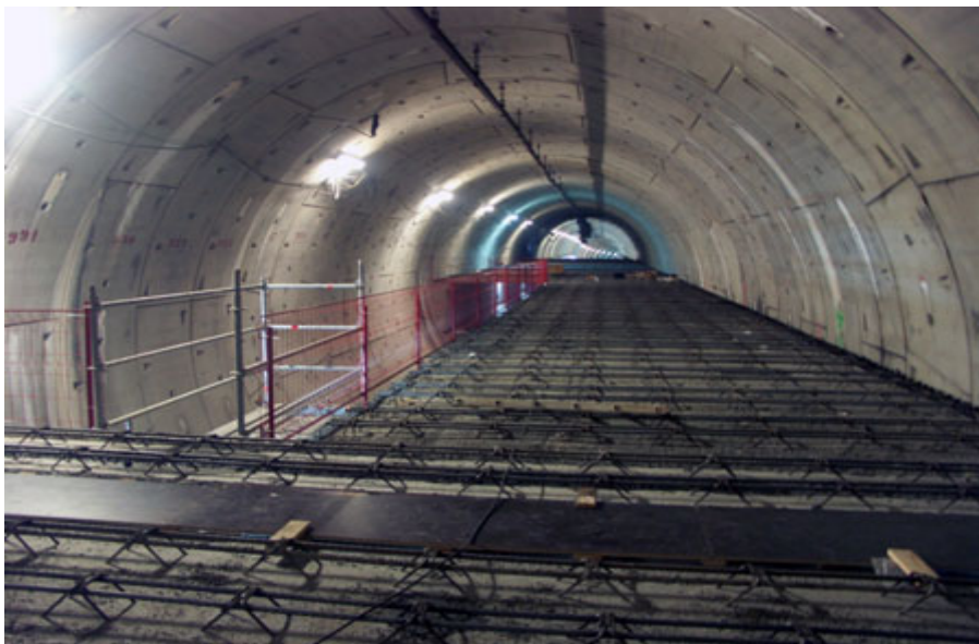
Imagen 3-20. Túnel circular de dovelas y parque de fabricación de dovelas.
