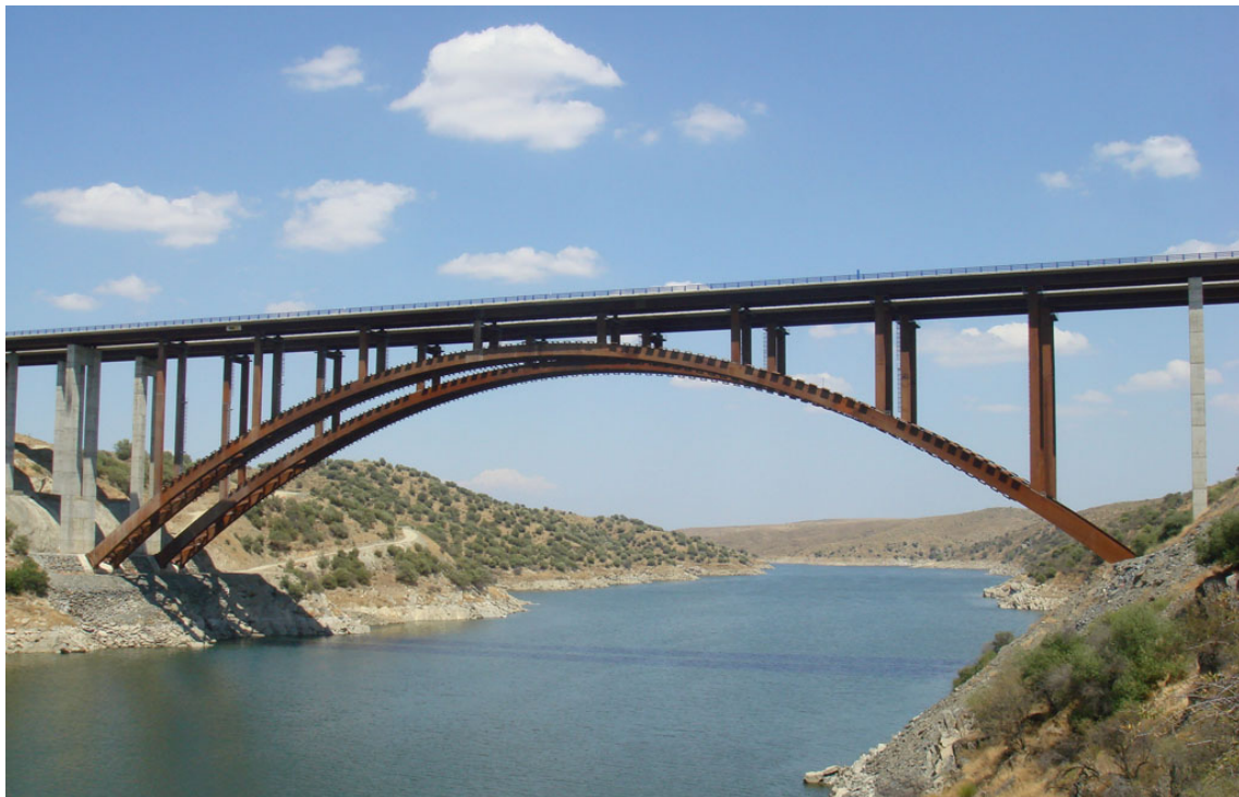
Imagen 3-18. Puentes arco metálico.
