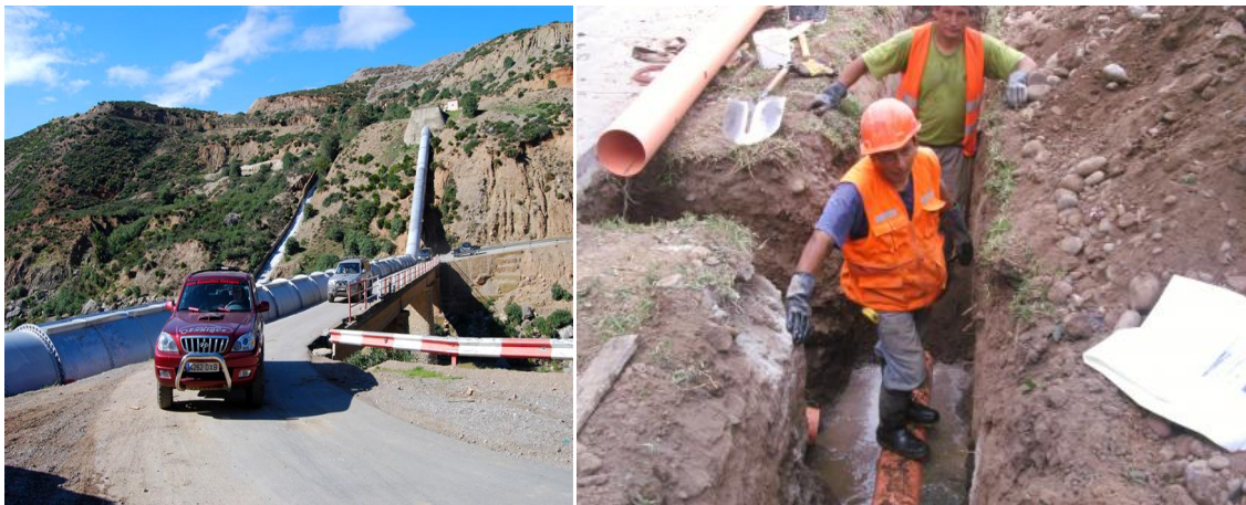
Imagen 3-26. Diferentes imágenes de reposición de servicios en obra.
