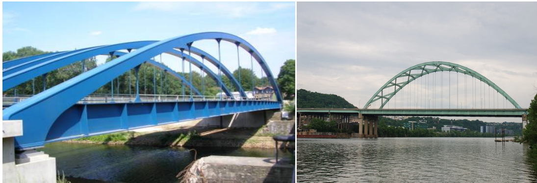
Imagen 3-17. Puentes arco-atirantado.
