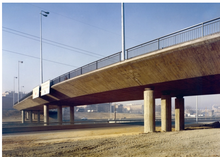
Imagen 3-14. Puente postensado in situ de canto constante.
