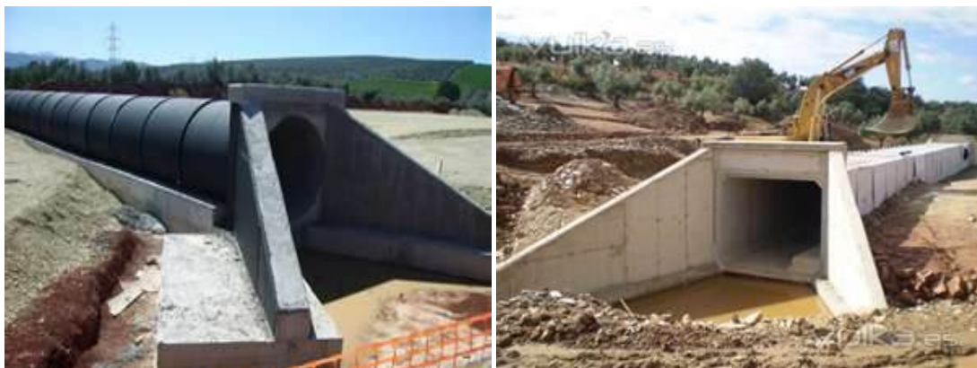
Imagen 3-23. Diferentes imágenes de obra de drenaje transversal.
