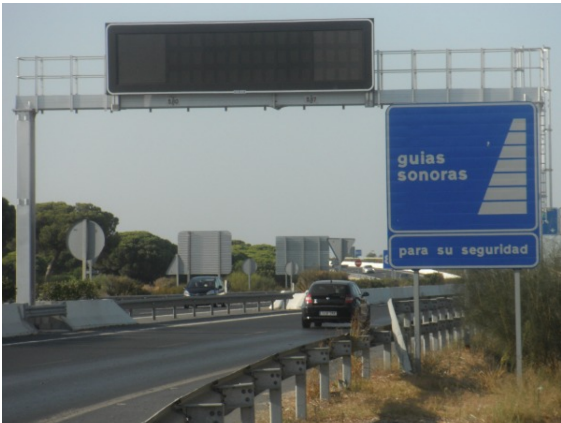
Imagen 3-24. Diferentes imágenes de paneles de obra.
