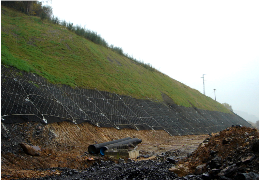
Imagen 3-27. Detalle de corrección geotécnica en talud.
