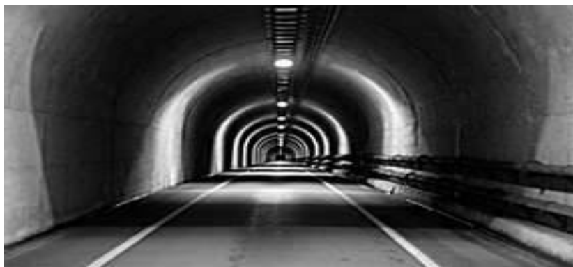
Imagen 3-22. Diferentes imágenes de túneles con geometría de herradura.
