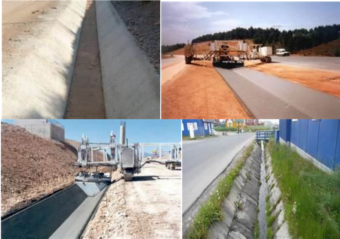
Image 3-6. Différentes typologies de fossés et d'exécution de celles-ci.
