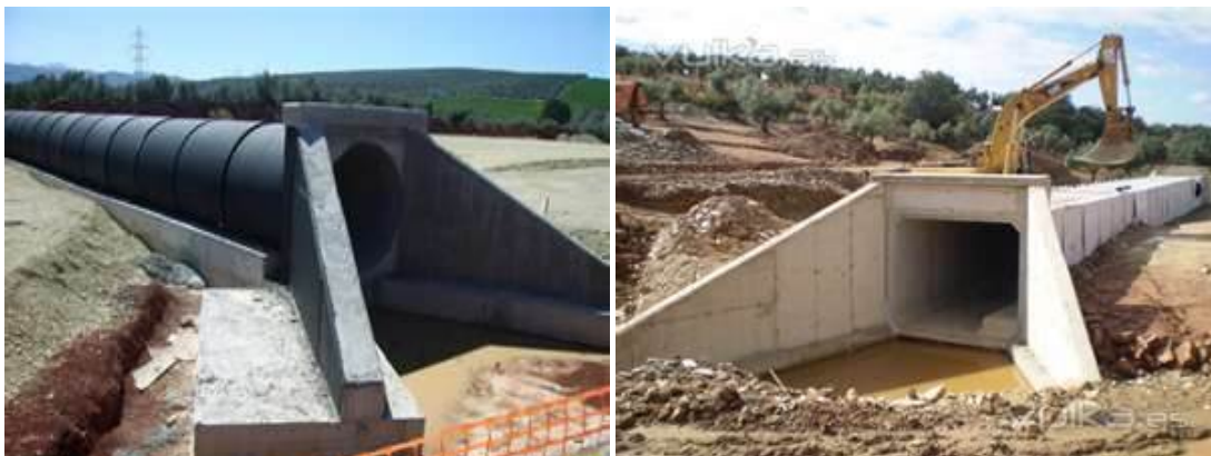
Image 3-23. Différentes images de travaux de drainage transversal.
