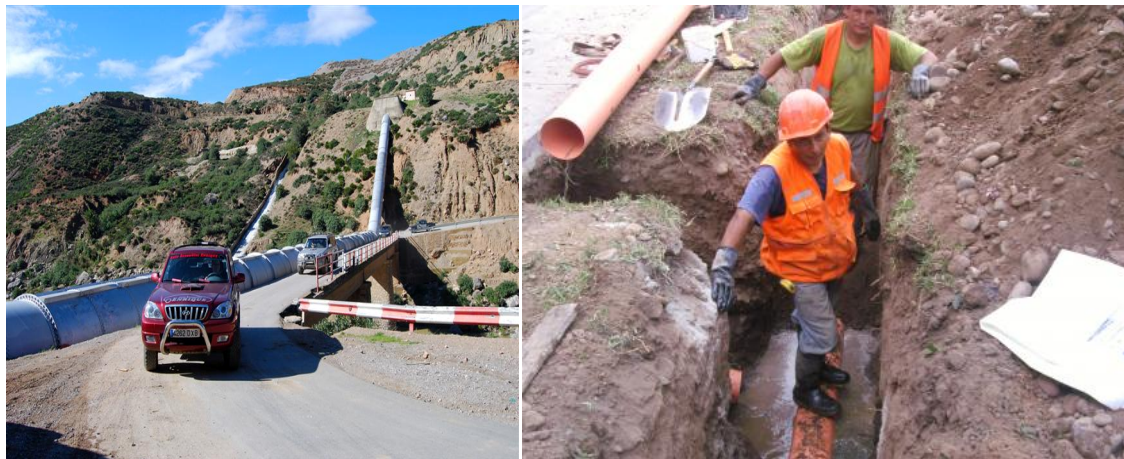
Image 3-26. Différentes images de Remplacement provisoire de services sur chantier.
