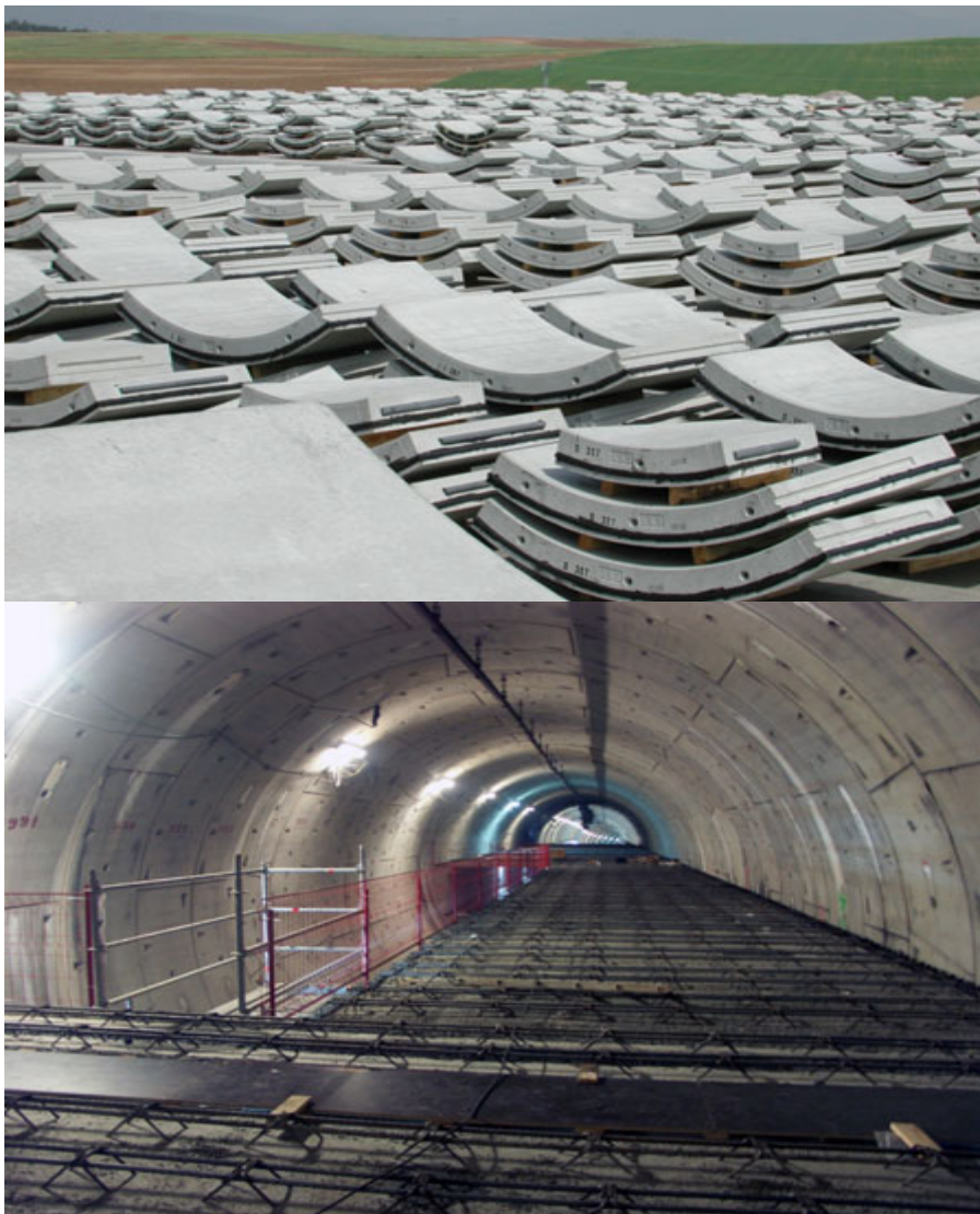
Image 3-20. Tunnel circulaire en voûtes et parc de fabrication des voûtes.
