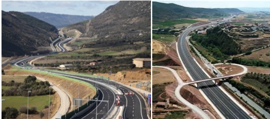
Image 3-29. Images des infrastructures avec des chemins de services.
