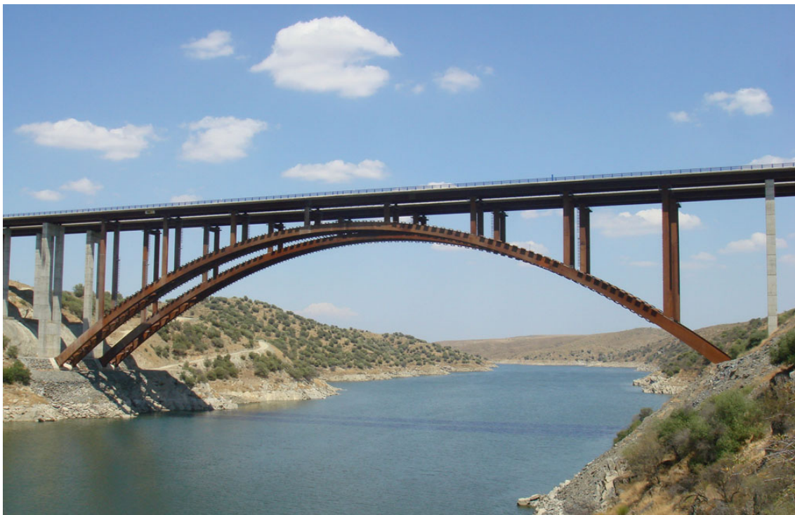
Image 3-18. Pont en arc métallique.
