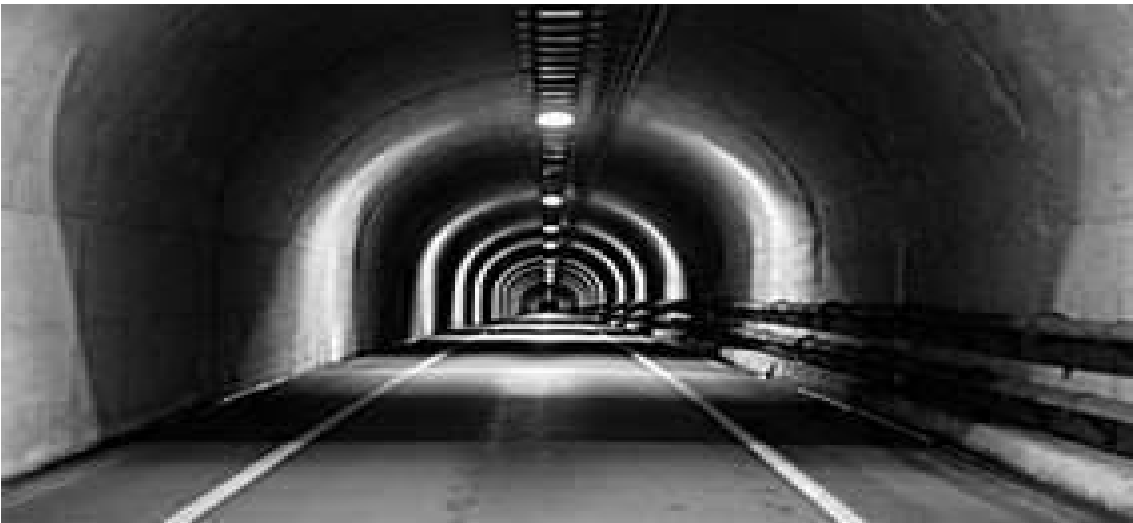
Image 3-22. Différentes images de tunnels avec géométrie en fer à cheval.
