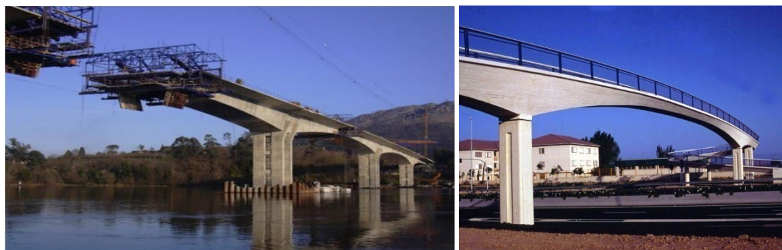
Image 3-15. Pont avec poutre d'épaisseur variable précontrainte in situ.
