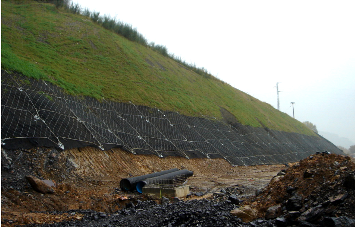
Image 3-27. Détail de la correction géotechnique en talus.
