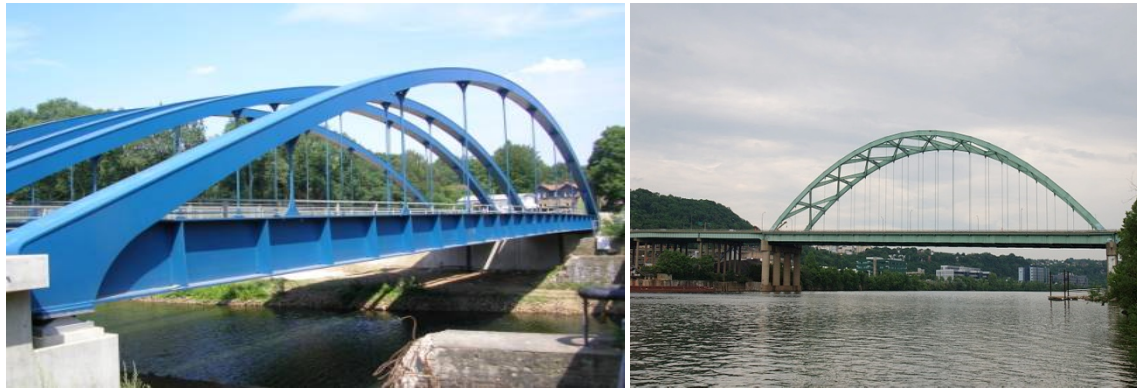
Image 3-17. Ponts en arc auto-ancré.
